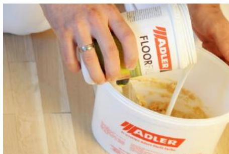
Bei verklebten Parkettböden können Sie feine Risse und Fugen vor dem letzten Schleifvorgang mit ADLER Floor-Fill verschließen. Dazu vermischen Sie ADLER Floor-Fill mit sauberem Schleifstaub. So passt die Farbe genau zum Boden.
