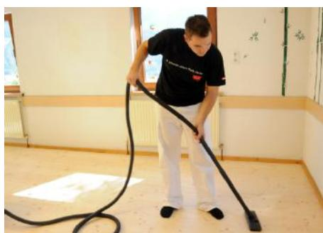
Entstauben und reinigen Sie den Boden gründlich, bevor Sie mit dem Versiegeln beginnen. Am besten saugen Sie ihn mit dem Staubsauger ab und wischen anschließend gut durch.
