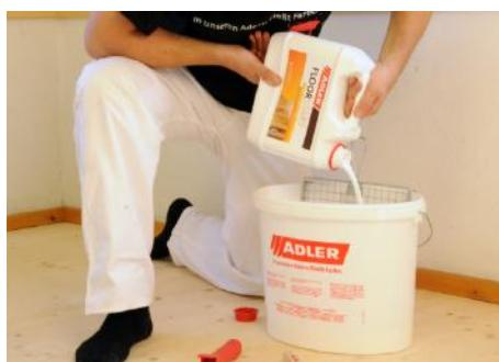
Füllen Sie die Grundierung ADLER Floor-Start in einen Farbeimer und bedienen Sie sich daraus. So verhindern Sie Flecken.
