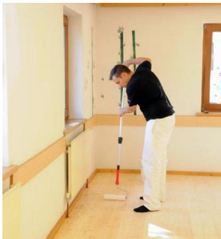
Der frisch geschliffene Boden saugt die Grundierung schnell auf.
