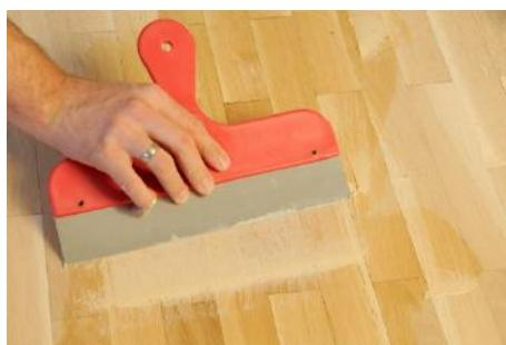
Mit dieser spachtelähnlichen Masse füllen Sie die Risse und Fugen satt auf. Lassen Sie die Stellen 1 – 1,5 Stunden durchtrocknen. Dann erfolgt der letzte Feinschliff.
