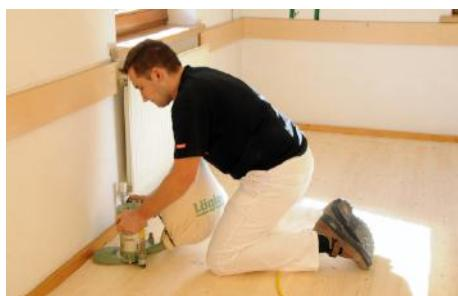
Die Ränder bearbeiten Sie bei jedem Schleifgang mit einer Randschleifmaschine.
