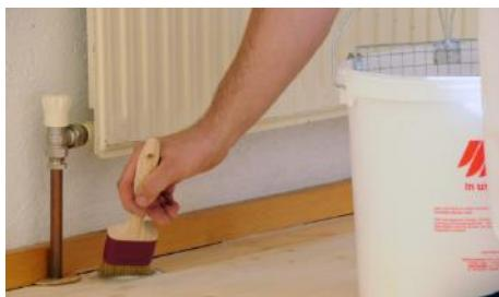
Vergessen Sie nicht parallel zu den Rollarbeiten mit dem Wasserlackpinsel die Ecken und Kanten zu beschneiden.
