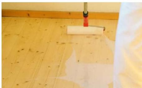
Gehen Sie gleich wie beim Grundieren vor. Da durch die Grundierung nun eine Schutzschicht vorhanden ist, können Sie ADLER Floor-Classic direkt auf den Boden schütten und gleichmäßig entlang der Holzmaserung verteilen.
