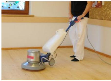
Nur geübte Heimwerker sollten dafür die Einscheibenschleifmaschine benutzen. Es geht um einiges schneller - durch die Kraft der Maschine können Sie jedoch Ihren Boden beschädigen.
