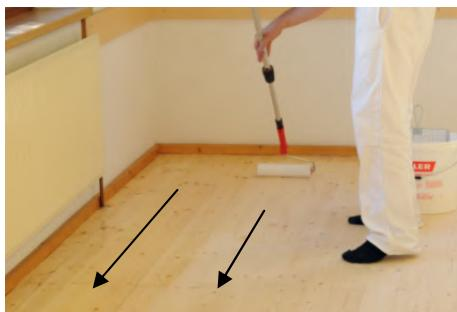
Arbeiten Sie immer in Bahnen und achten Sie auf eine gleichmäßige Überlappung der einzelnen Abschnitte.
