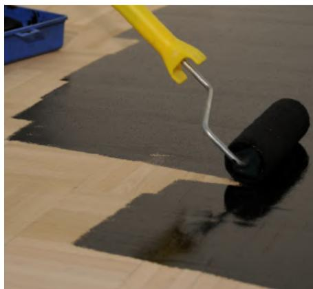
Tragen Sie das Öl mit Hilfe einer Rolle dünn auf. Teilen Sie große Flächen in kleinere zu bearbeitende Abschnitte ein. So kann ein vorzeitiges Antrocknen des Öles vermieden werden.
