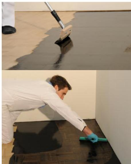
Alternativ können Sie Legno-Color auch mit einer Fußbodenstreichbürste auftragen bzw. mit einer Spachtel bzw. einem Gummiwischer aufrakeln.
